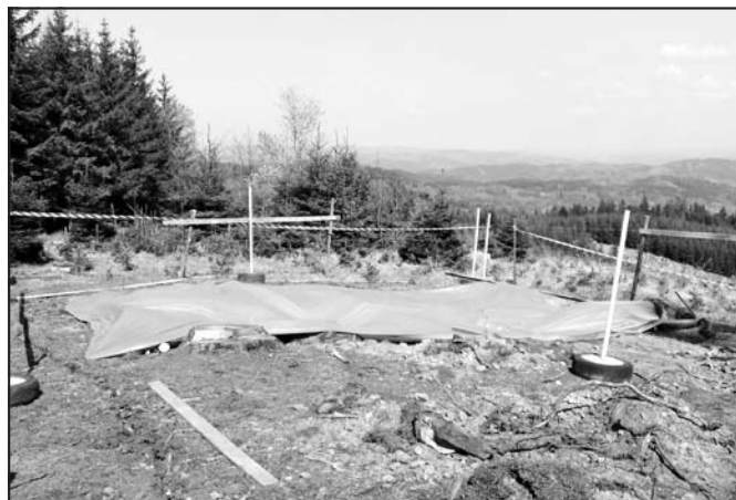
Výkop sondy v místě stavby.
