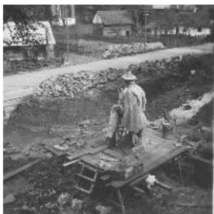
1940 – 1941 Práce na soše Portáše, v pozadí stavba mostu přes silnici a regulace potoka
