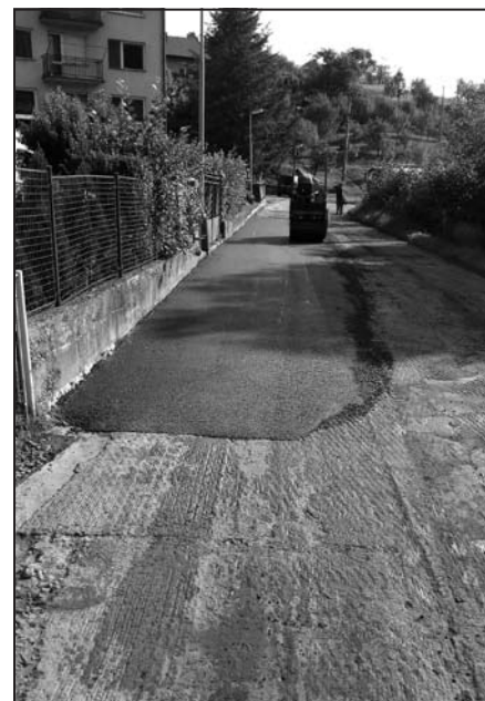
Oprava místní komunikace Sokolská – 2. etapa
